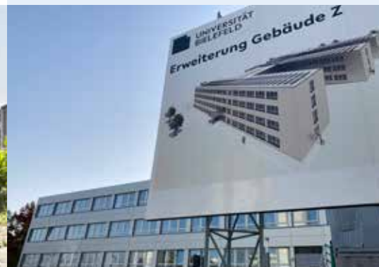
Auch am erst 2018 fertig gestellten Gebäude Z wird gebaut. Durch die Erweiterung (genannt „Z2“) verdoppelt sich die nutzbare Fläche des Gebäudes.
